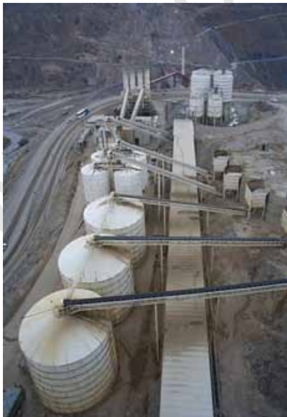
Nhà máy trộn bê tông tại công trình Benni Haroun (Algeria) có băng tải ướt, khu sản xuất nước đá và các xi lô
