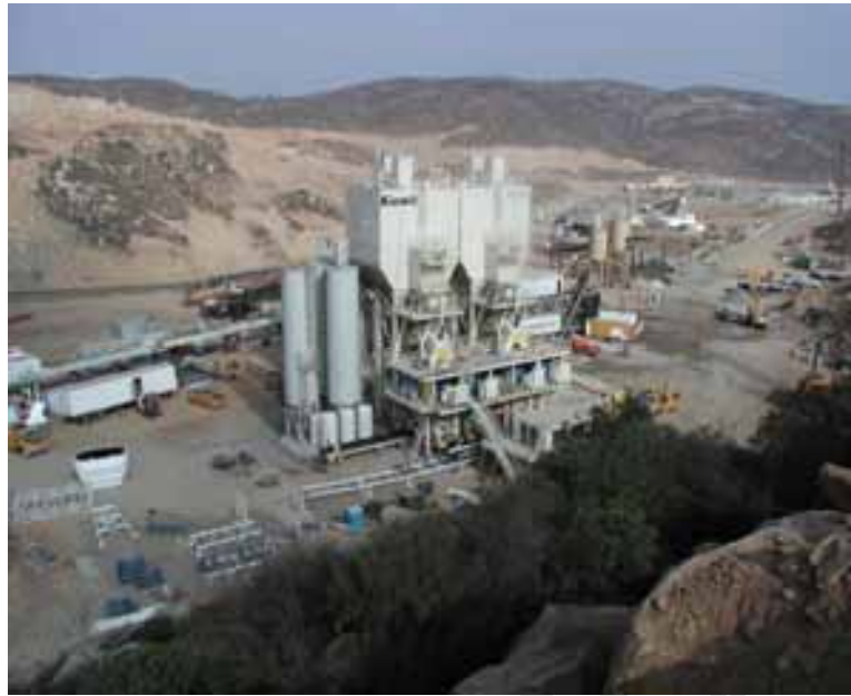
thí nghiệm hiện trường tại công trình thủy điện Sơn La.
