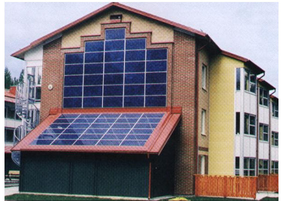
Hình 3.16. Lắp pin mặt trời ở nhà
