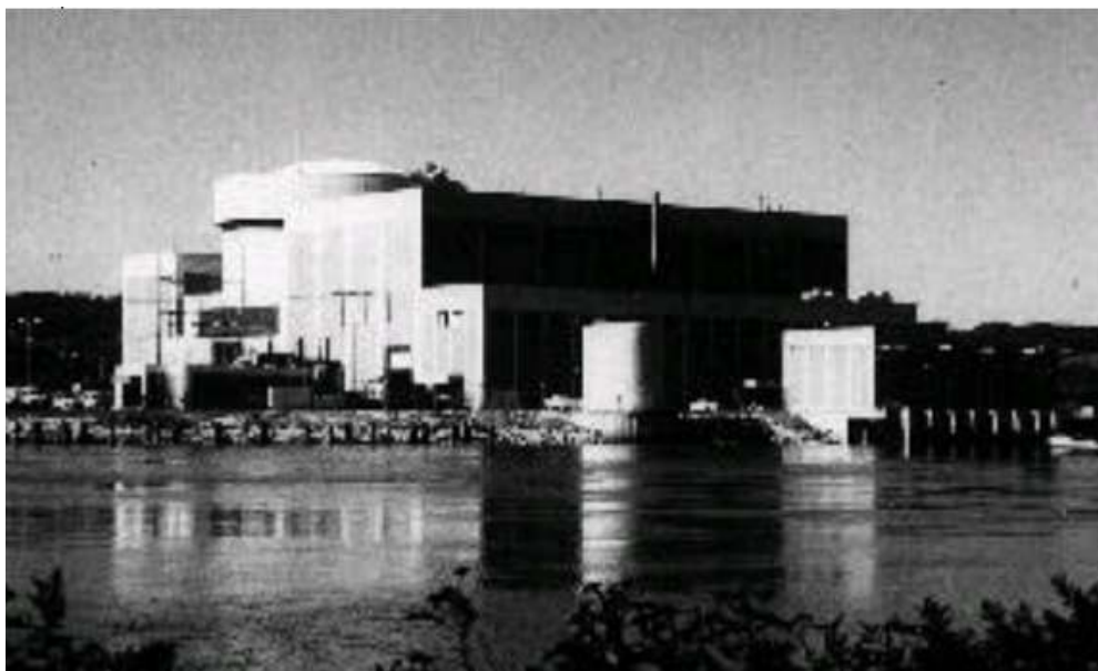
Nhà máy điện hạt nhân tại Fort Calhoun, Nebraska
