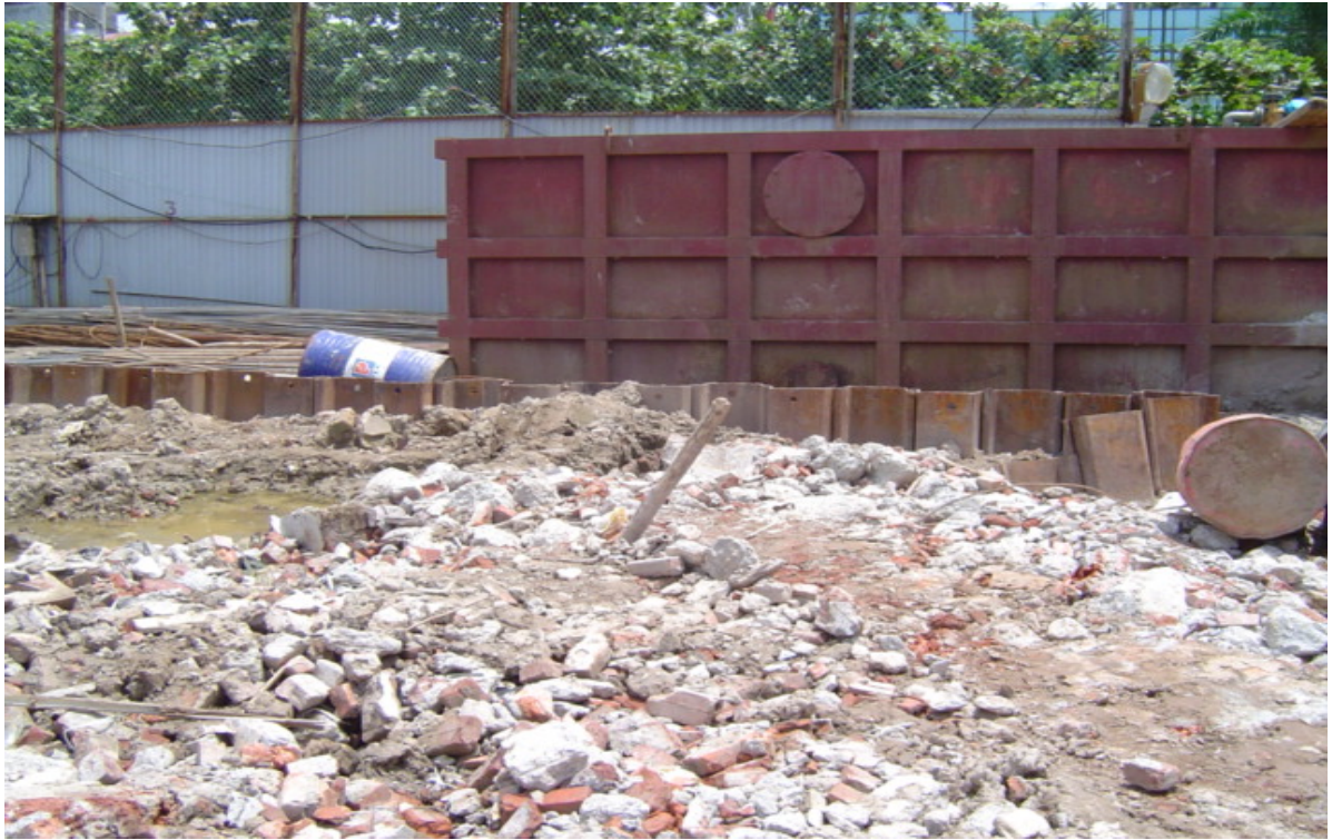
Hình 6.1.2 Cừ LASEN trên công trình xây dựng nhà 124 Minh Khai ( Tổng công ty xây lắp máy Việt Nam LILAMA )
