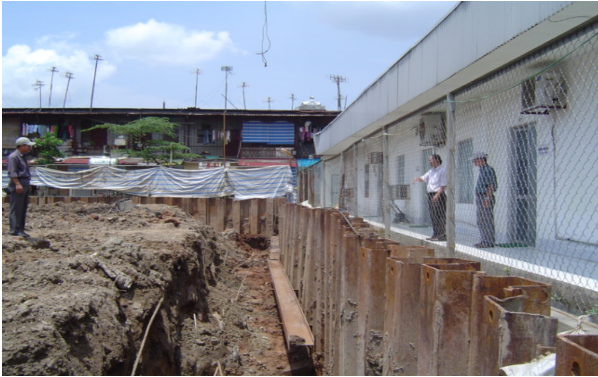
Hình 6.1.3 Cừ LASER trong quá trình đào hố móng
