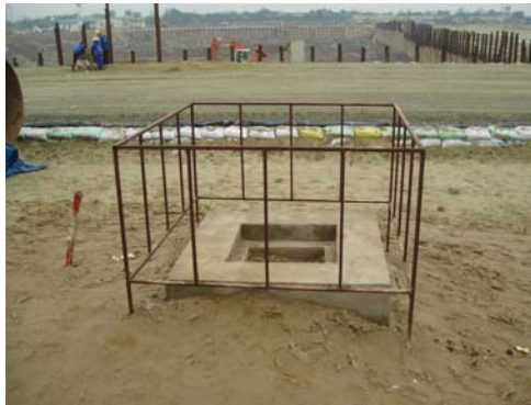
H.7 Mốc khống chế mặt bằng và độ cao
