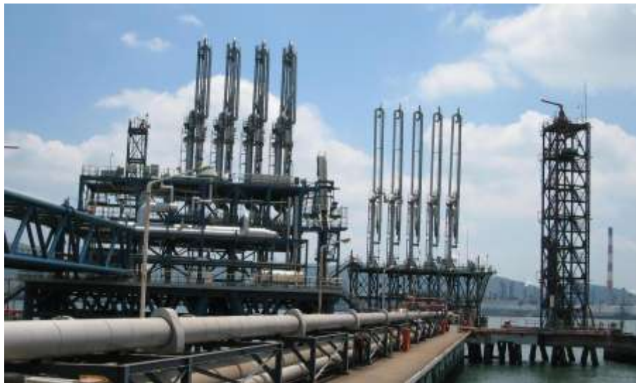
Hình H-27 - Bến xuất sản phẩm lỏng bằng đường thủy của Nhà máy lọc dầu
