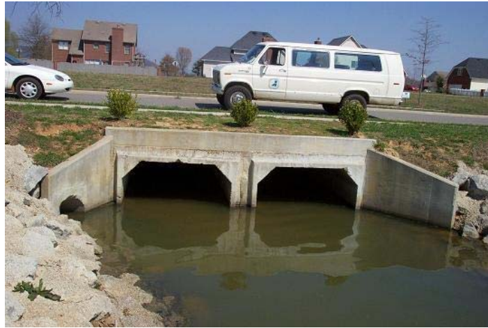
Cống ngầm mặt cắt hình hộp
