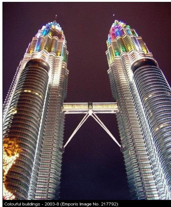
Hình 1. 2 Petronas Twin Tower
