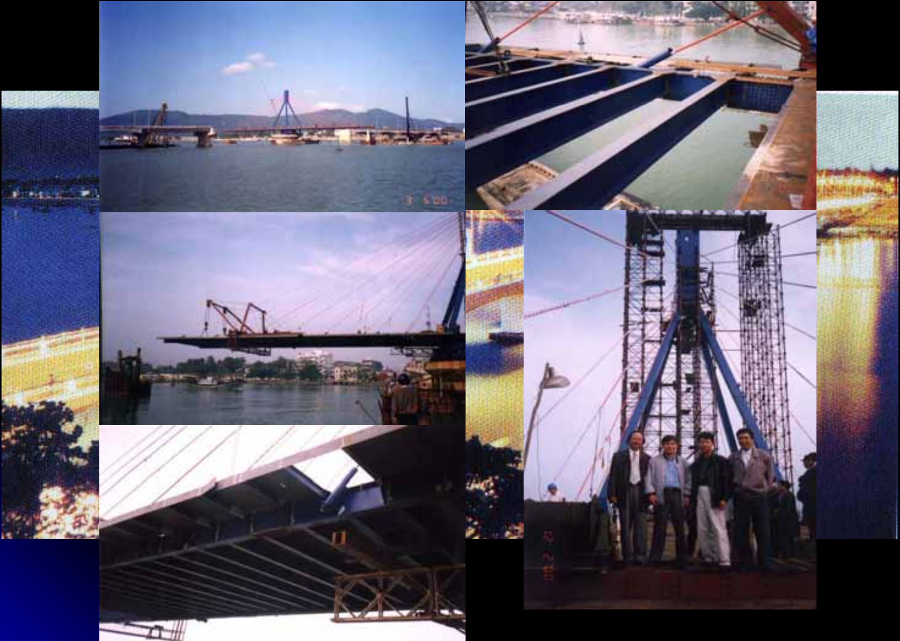
Một số hình ảnh trong quá trình thi công Cầu Sông Hàn-Đà Nẵng
