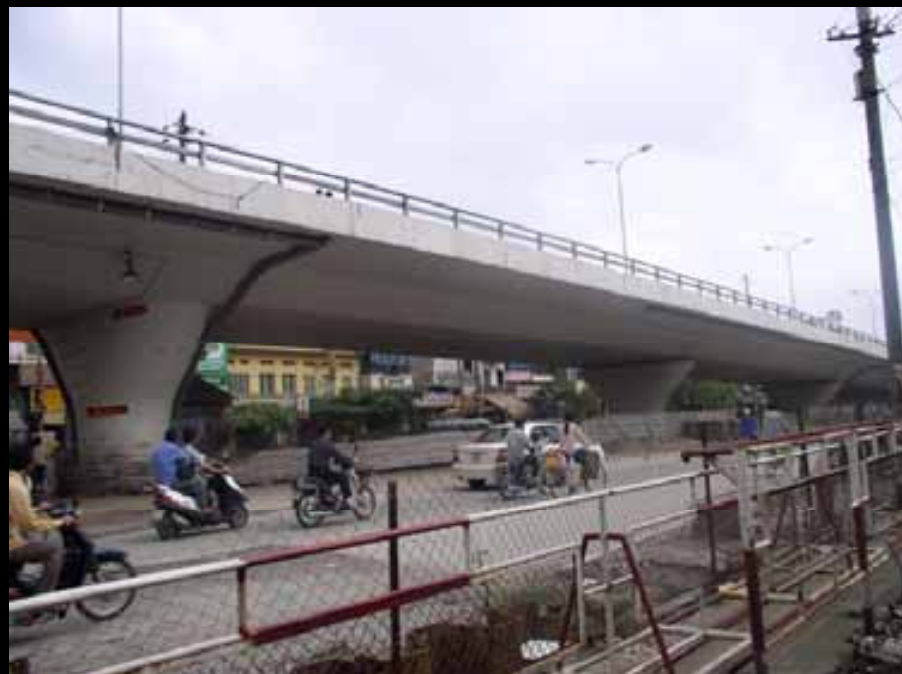
KẾT CẤU NHỊP CẦU BẢN CÓ KHOÉT LỖ (CẦU VƯỢT NGÃ TƯ VỌNG)
