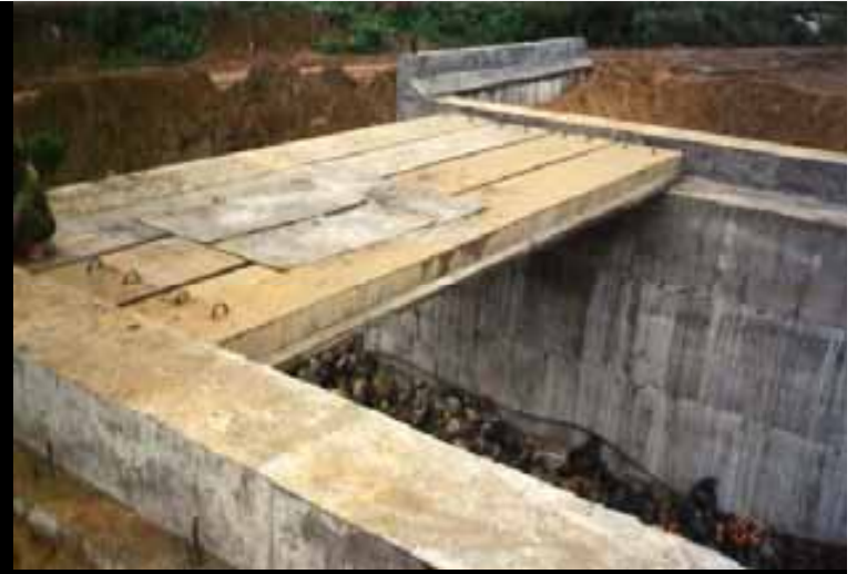
Cầu Bản BTCTU'ST (Đường Hồ chí Minh)
