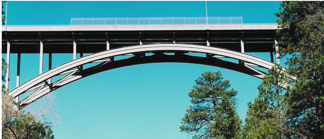
Canyon Bridge, Los Alamos, NM
