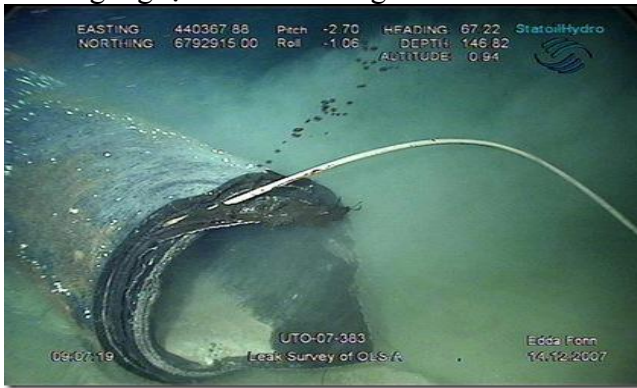
hình ảnh 1 đoạn đường ống dẫn dầu bị
