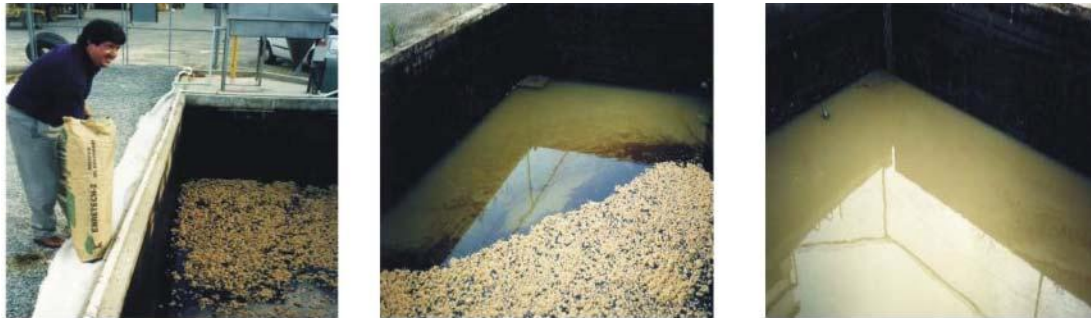
Hình 24. Sử dụng Enretech cellusorb để hấp thụ dầu.
