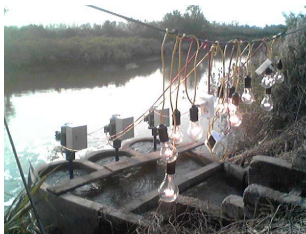
Hình 3. Trạm phát điện sử dụng năng lượng thủy triều (03 tổ máy x1 kW).
