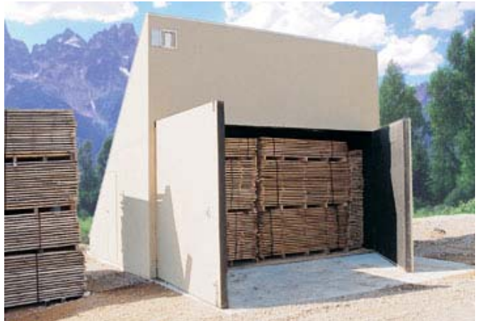
Hình 4.80. Hệ thống sấy gỗ năng lượng mặt trời.
