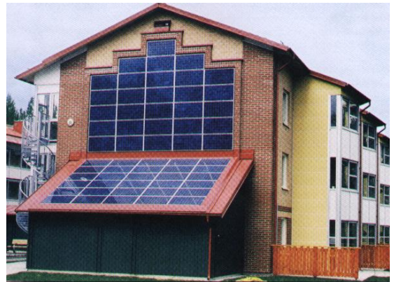
Hình 3.16. Lắp pin mặt trời ở nhà
