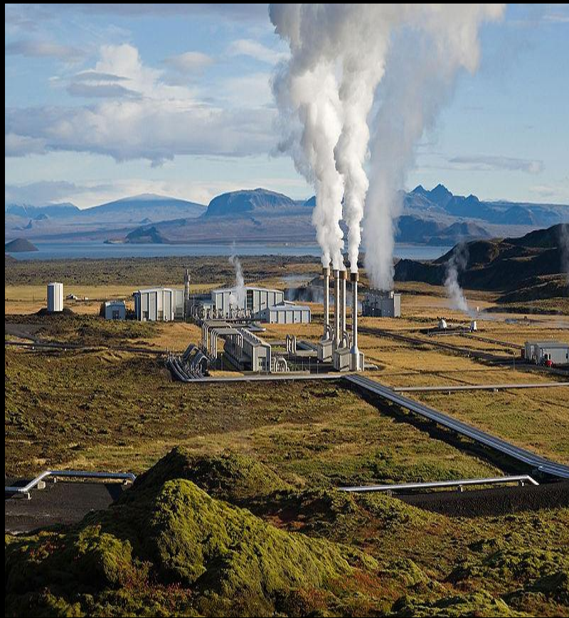
Nhà máy điện địa nhiệt Nesjavellir ở Iceland
