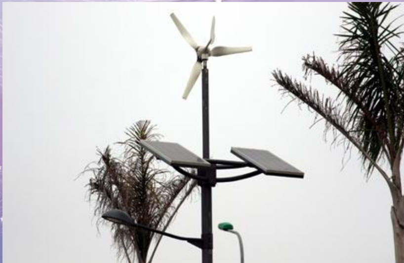
Hệ thống đèn chạy bằng năng lượng mặt trời và gió đặt tại Khu Công nghệ cao Hòa Lạc (Hà Nội)
