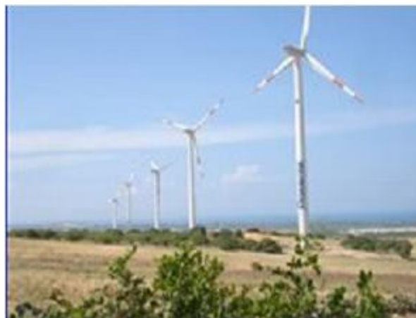
Hình 3 : Năm tổ máy của nhà máy điện gió tầm cỡ MW đầu tiên ở Việt Nam ở xã Bình Thạnh, huyện Tuy Phong , tỉnh Bình Thuận.
