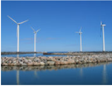
Tuốc bin gió tại bờ biển Đan Mạch
