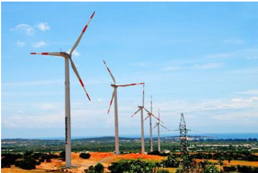
(5 tổ máy 1.5MW đầu tiên của nhà máy điện gió Tuy Phong, Bình Thuận)
