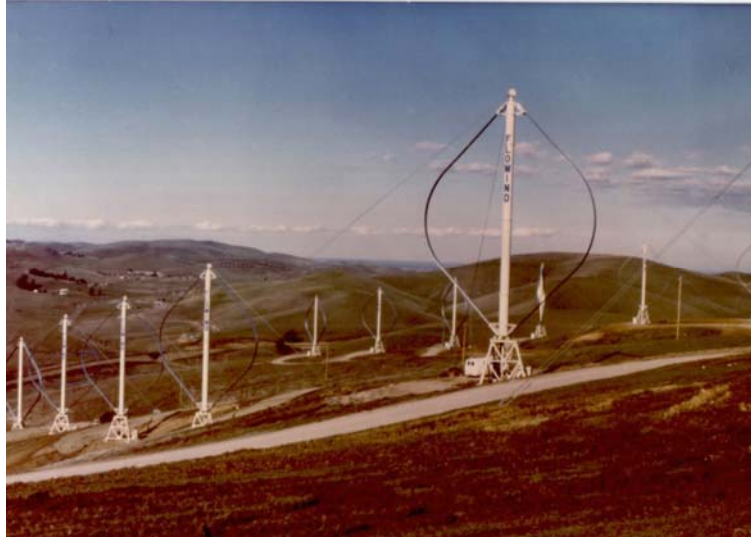
Hình 5: Turbine Gió Trục Dọc - VAWT - Ở California
