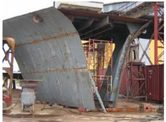
Hình 8.4 Lắp ráp tổng đoạn lái
