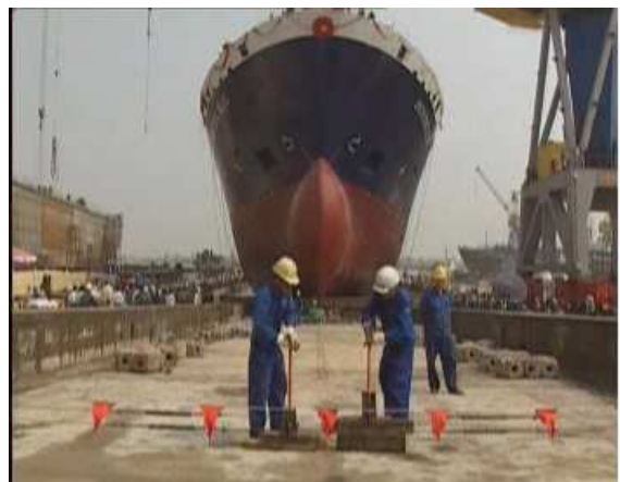
Hình 10.5: Cắt cáp hạ thủy tàu
