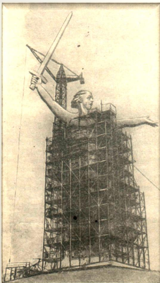
Рис 8. Башенный кран на строительстве главного монумента на Мамаевом кургане высотой 82 м (г. Волгоград, 1967 г.)
