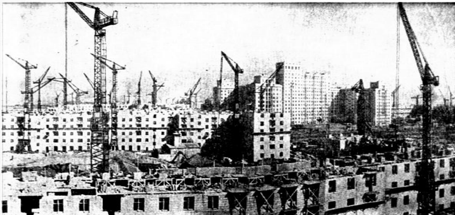
Рис. 2. Башенные краны на строительстве зданий с кирпичными стенами (Москва, 1955 г.)
