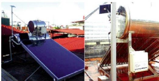
Hình 6: a (bên trái) TBNNMT tấm-ống và b (phải) TBNNMT ống
