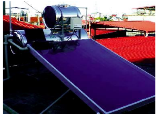
Hình 3: Hệ đo và thu thập số liệu sau khi lắp đặt
