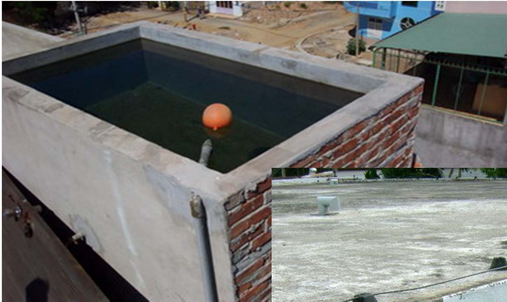
Bể chứa nước nổi bằng kết cấu gạch
