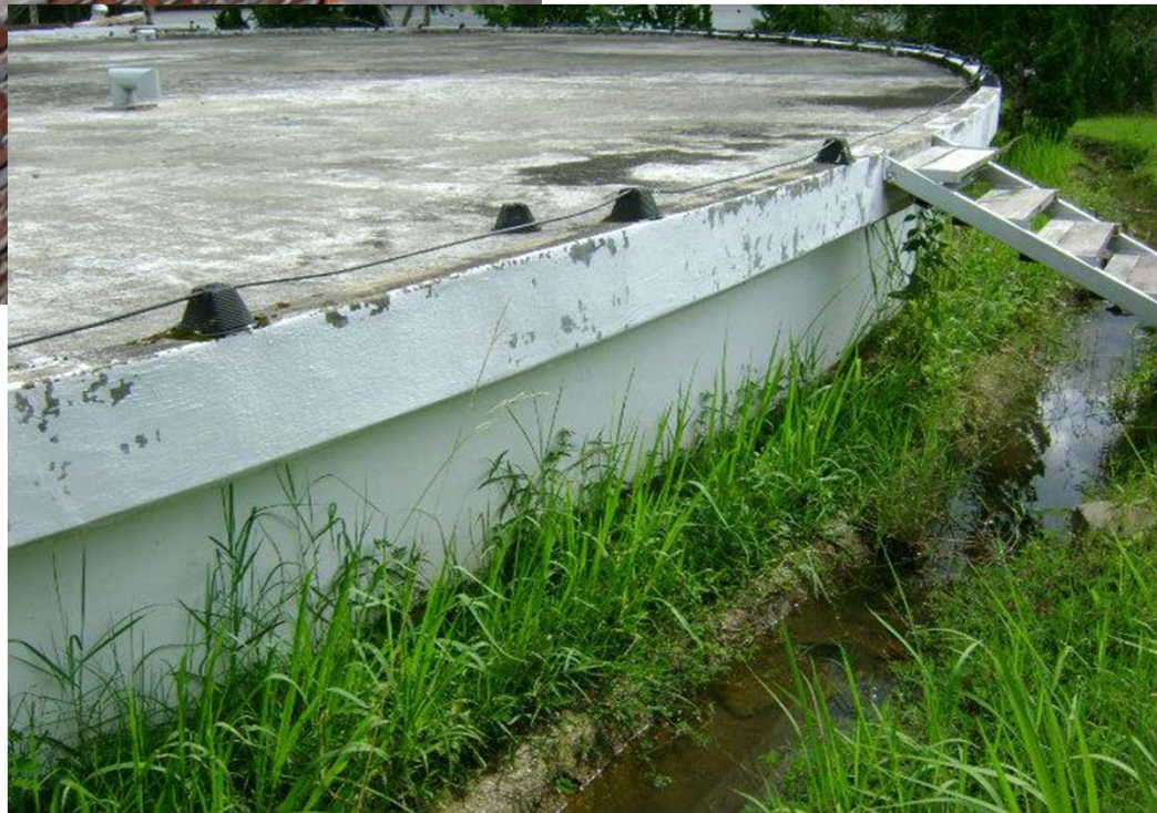
Bể chứa BTCT đổ toàn khối
