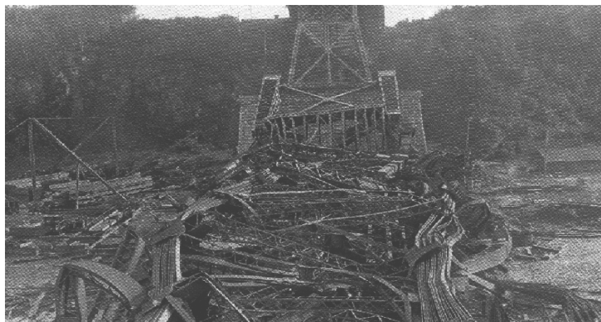
Hình 1-9b: Cầu dầm hẫng Quebec khi bị sụp đổ do lắp ráp
