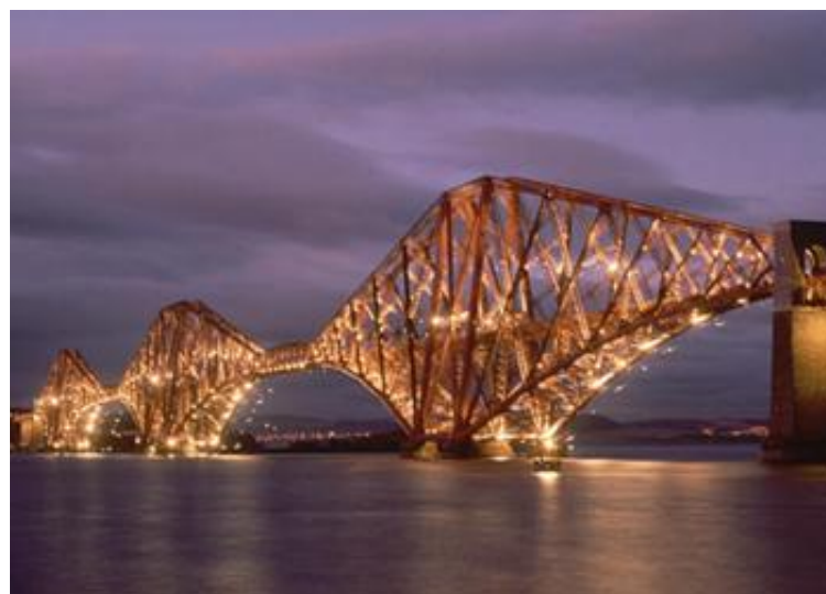
Hình 3.5: Cầu dàn Firth of Forth có nhịp 521m lớn thứ 2 thế giới, hoàn thành năm 1890
