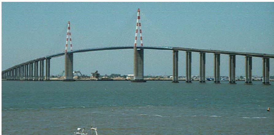
Hình 1-19: Cầu Saint Nazaire (Pháp) nhịp chính 404m xây dựng năm 1975
