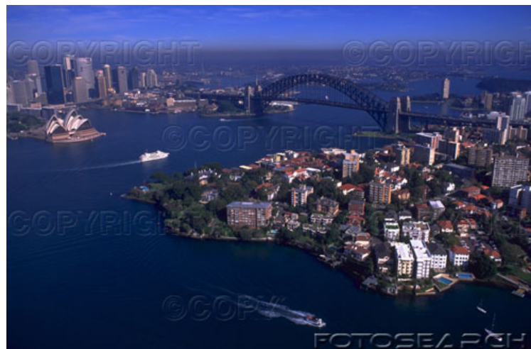
Hình 1-12: Cầu Sydney Harbor nhịp chính 503m, đỉnh vòm cách mặt nước 137m
