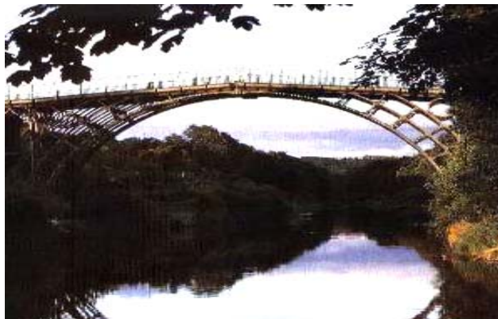
Hình 1-2: Cầu vòm gang đầu tiên được xây dựng ở Anh năm 1776-1779
