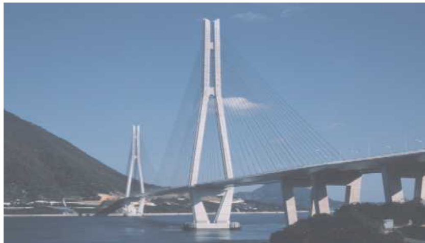
Hình 1-22: Cầu Tataru nhịp chính 890m xây dựng năm 1999
