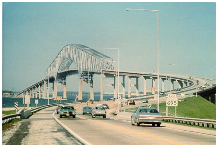
Hình 3.16: Cầu vòm Francis Scottkey (Mỹ) có đường xe chạy dưới
