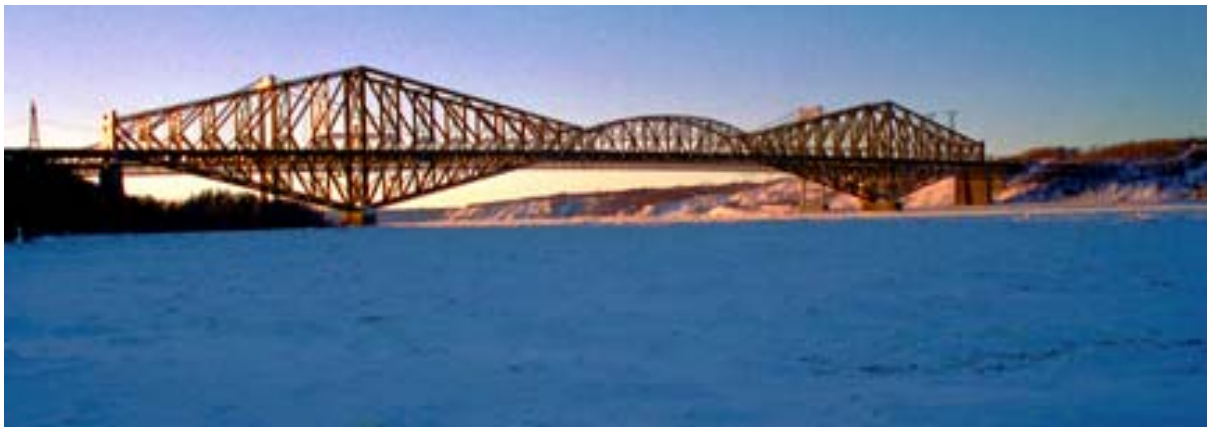
Hình 3.4: Cầu dàn Ponte de Quebec (Canada) có nhịp 549m lớn nhất thế giới, hoàn thành năm 1917
