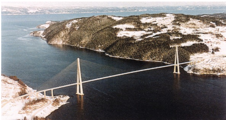
Hình 1-20: Cầu Skarnsundet (Na Uy) nhịp 503m xây dựng năm 1991
