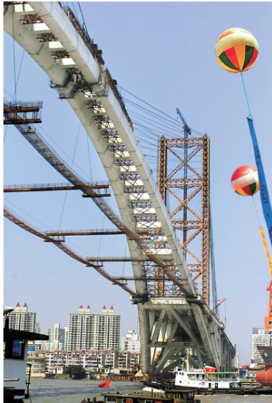
Hình 1-27: Cầu Lupu là cầu vòm có nhịp lớn nhất thế giới 550m, hoàn thành 2003
