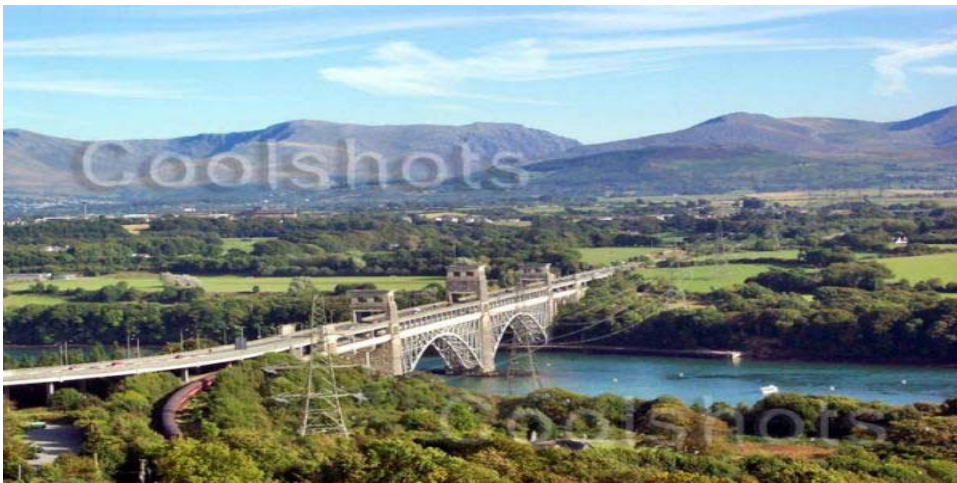
Hình 1-6: Cầu Britania về sau này được nâng cấp có 2 tầng và tăng cường kết cấu nhịp dạng vòm thép
