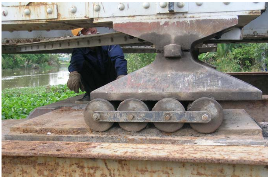
Hình 6.9: Gối con quay di động
