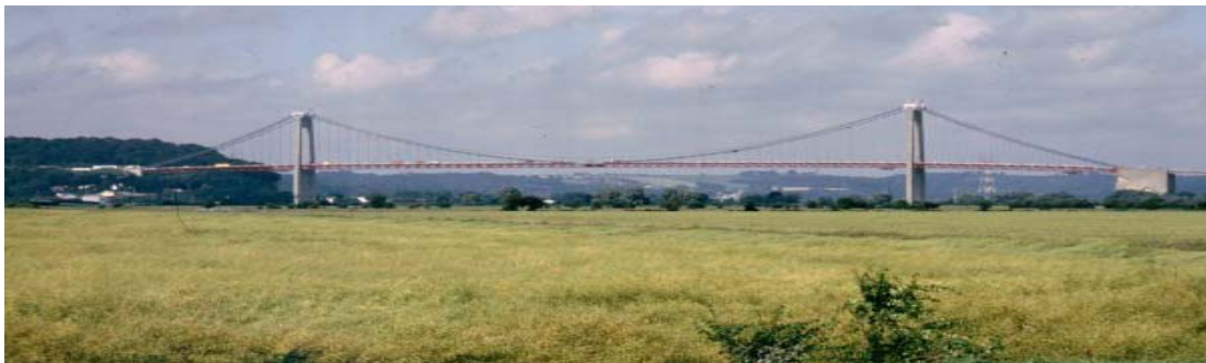
Hình 1-35: Cầu Tancarville (Pháp) với nhịp chính 608m, phải thay cáp
