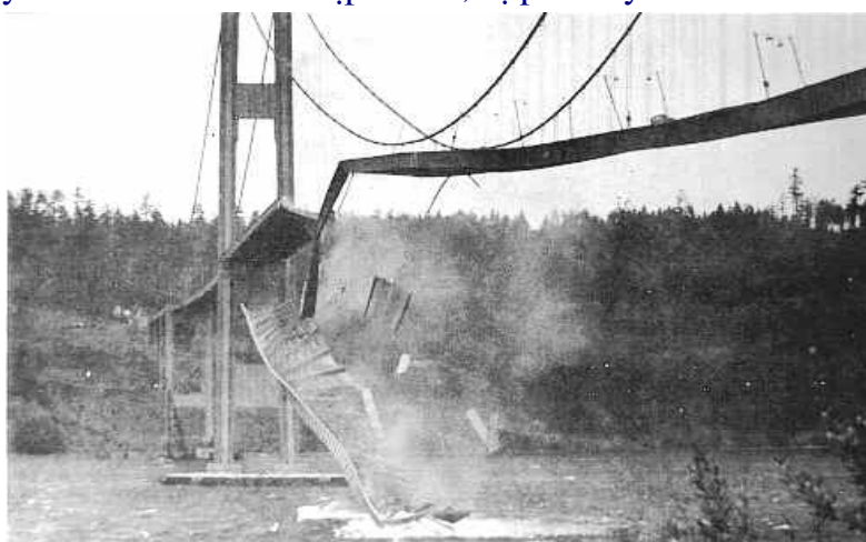
Hình 1-17: Cầu Tacoma bị phá huỷ do bão
