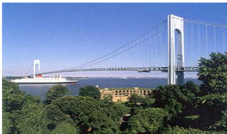
Hình 1-16: Cầu Verrzano nhịp chính 1298.5m
