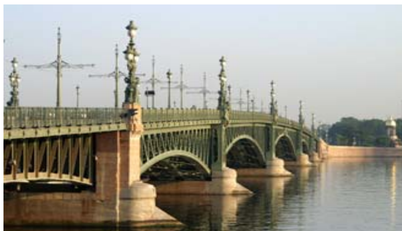
Hình 1-3: Cầu Kerbetze (Trinity) có 7 nhịp vòm từ 48-52m, thanh vòm có tiết diện chữ I
