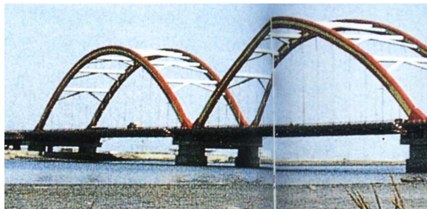
Hình 1-38: Tianjin (Trung Quốc)-vòm thép nhồi bê tông
