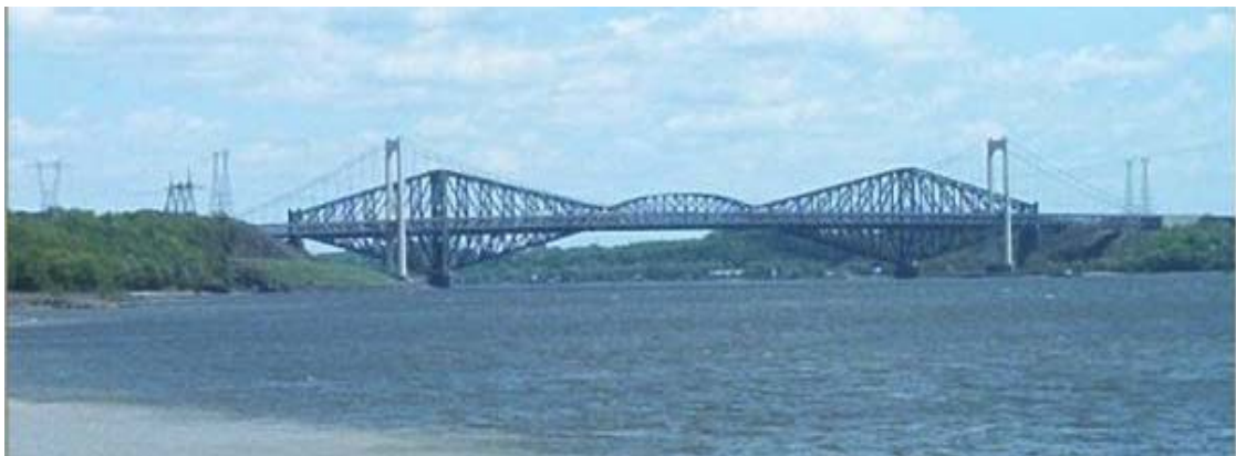
Hình 1-9a: Cầu dầm hẫng Quebec ở Canada có nhịp lớn nhất thế giới 549m
