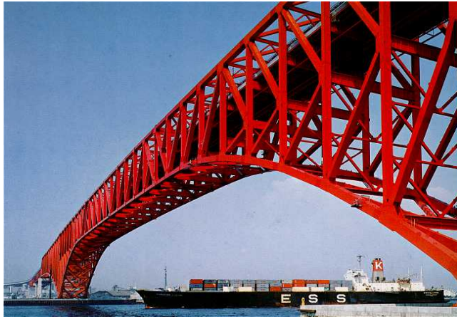
Hình 3.9: Cầu dàn Mimato (Nhật Bản) có đường xe chạy trên
