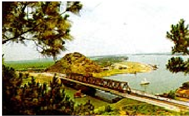
Hình 1-30: Cầu Hàm Rồng được xây dựng lại bằng dàn liên tục 2 nhịp
