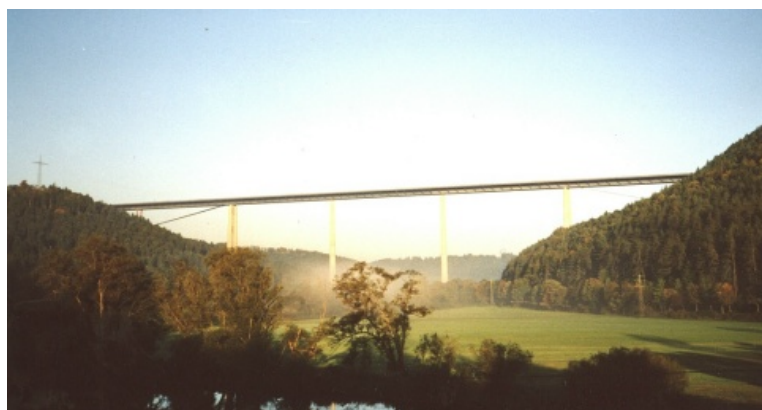
Hình 3.2: Cầu dầm thép Neck Artalbrucke-1 (Đức) nhịp 263m lớn nhì thế giới, hoàn thành năm 1978
