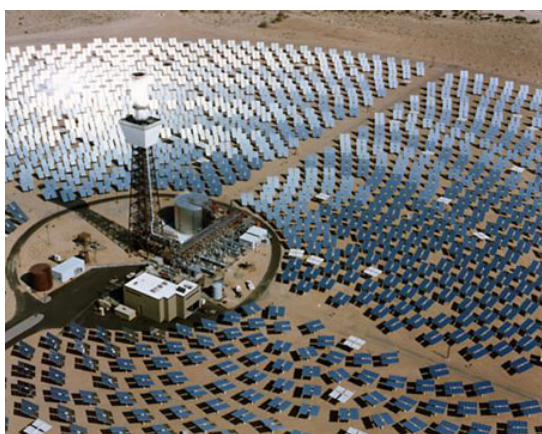
Hình 3.2. Nhà máy điện mặt trời
