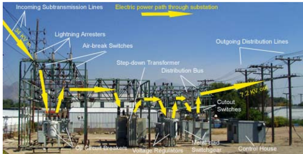
Hình : Trạm biến áp
