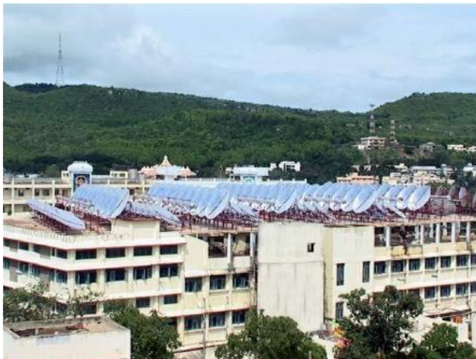
Hình 4.42. Hệ thống cung cấp hơi cho bếp nấu ở Ấn độ
