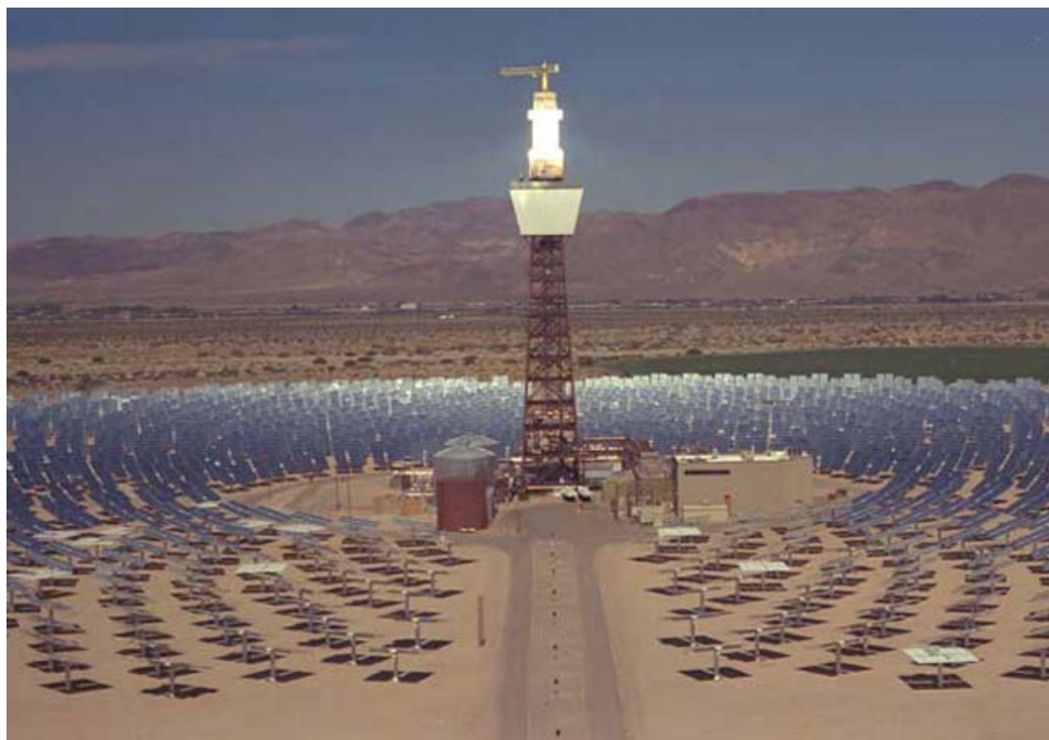
Hình 4.14. Nhà máy nhiệt điện mặt trời dùng hệ gương phản xạ.
