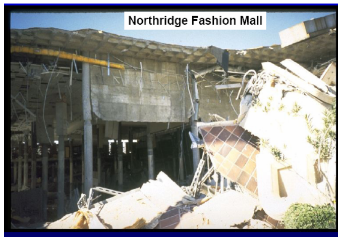
c)- Động đất Northridge (Mỹ) năm 1994
