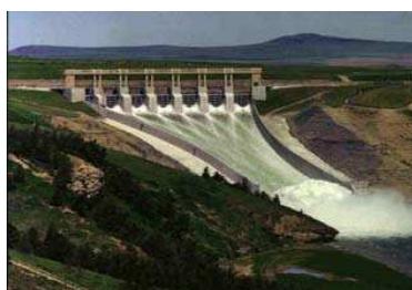
Đập tràn xả lũ – Hồ chứa
