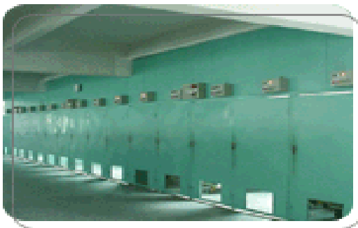
Burn-in Room (outside) / Bên ngoài Gian thử nhiệt
